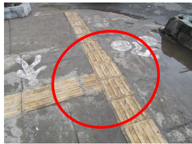
Posisi tektile di ujung pertigaan belum diperbaiki sesuai standar
