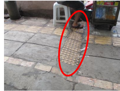
Posisi tektile pada ramp in/out belum diperbaiki,
