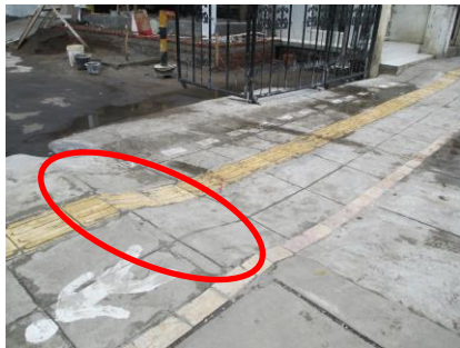
Belum ada tektile pada ramp in/out
