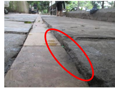
Posisi tektile pada ramp in/out belum diperbaiki,
