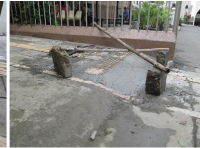
Posisi tektile pada ramp in/out dalam perbaikan
