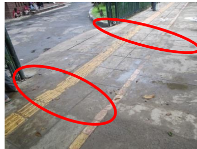
Belum ada tektile pada ramp in/out
