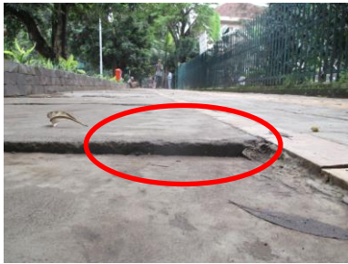
Belum ada tektile pada ramp in/out
