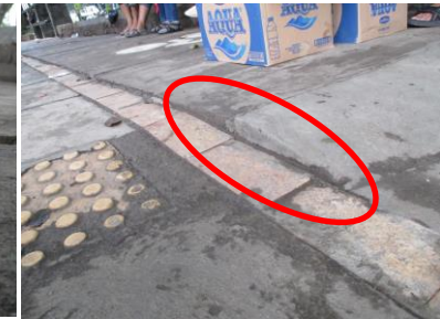
Posisi tektile pada ramp in/out dalam perbaikan
